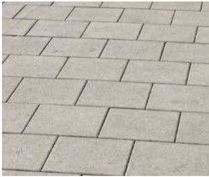
Revêtement de trottoir avec dalles en béton, dim. 30x30cm, ép. 8cm, modèle Kronimus Kronit NR 131
