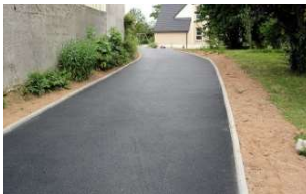
Chaussée en enrobés
